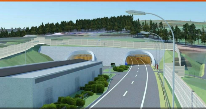
Północny portal tunelu, Budynki techniczne, Maszt radiowy
