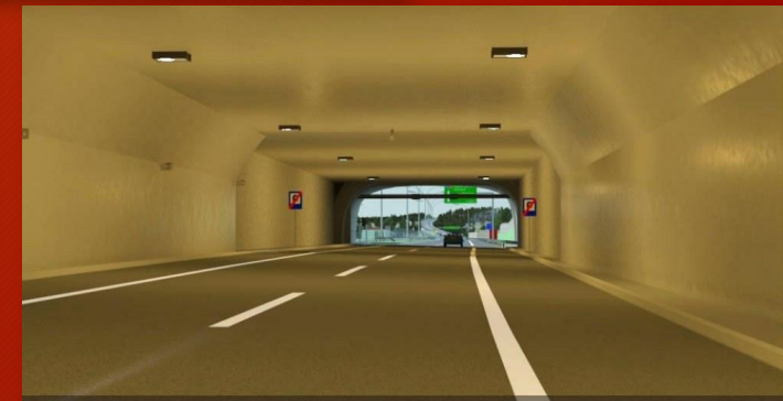
Południowy portal tunelu
