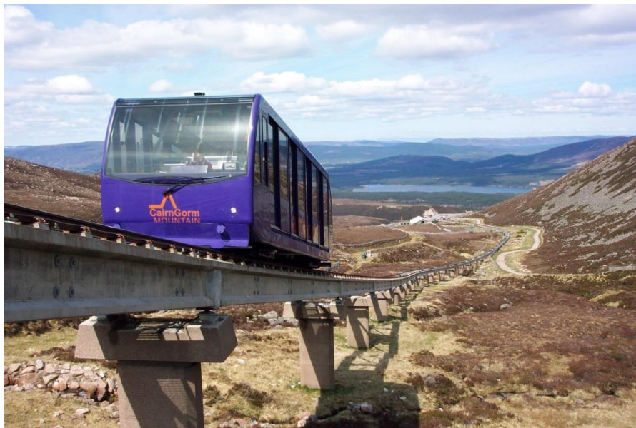
Zdj.9 Kolej Cairngorm w Szkocji – estakada z modułów betonowych
